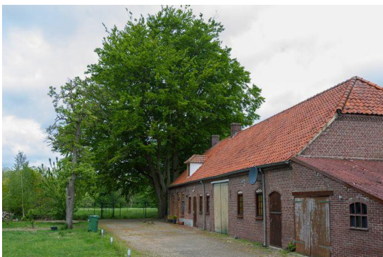
Geheel oogt als een langgevelboerderij
